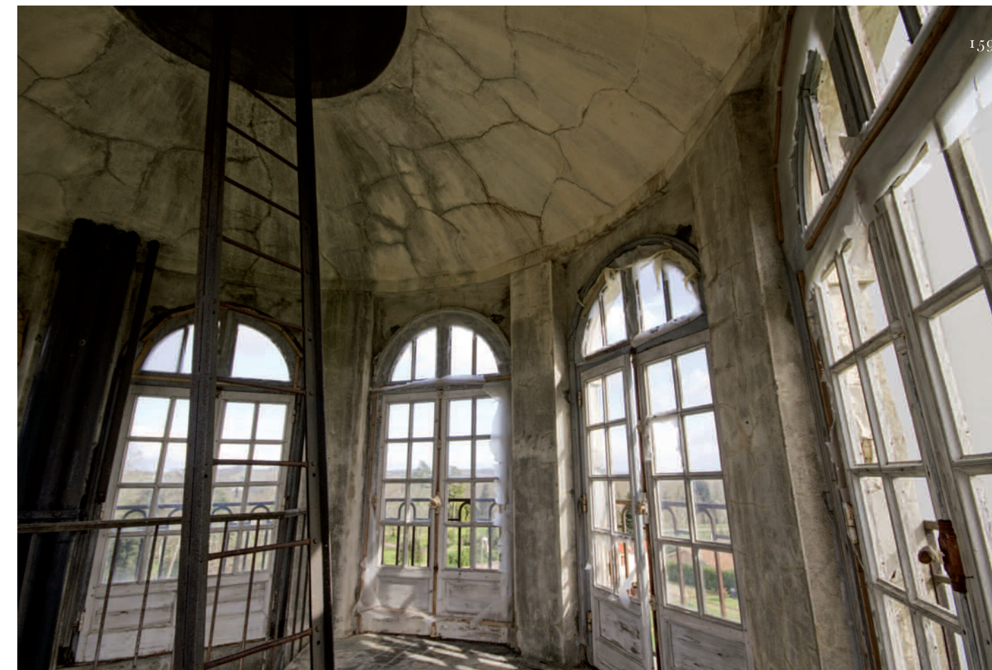
Vue de la gloriette. © Fonds Thévenot, P. Latrémolière, 2014.
